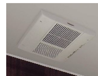
暖房換気乾燥機で 入浴前に浴室を暖めておけば、 一番風呂でもあったか。
